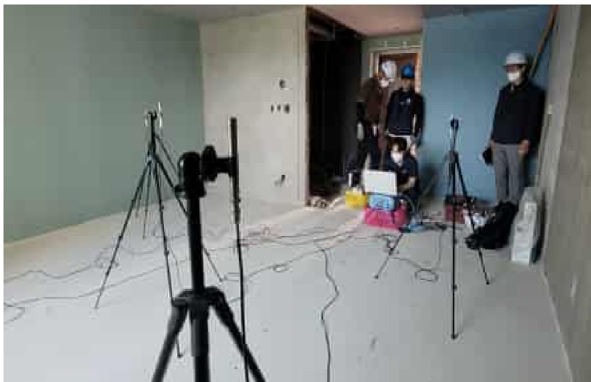
성능검사기관(국토안전관리원) 현장 입회 - 수음실 측정 절차 확인
